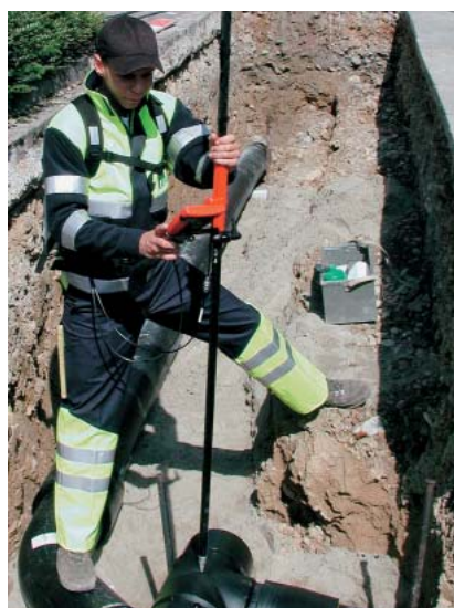
Abb. 9 GPS-Messung mit Rover.
